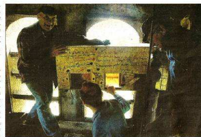
Installation du nichoir dans le clocher.
