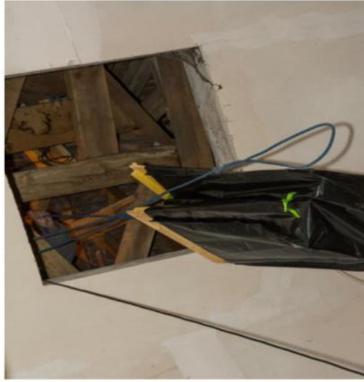
Les planches ont été hissées une à une jusqu'au clocher.
