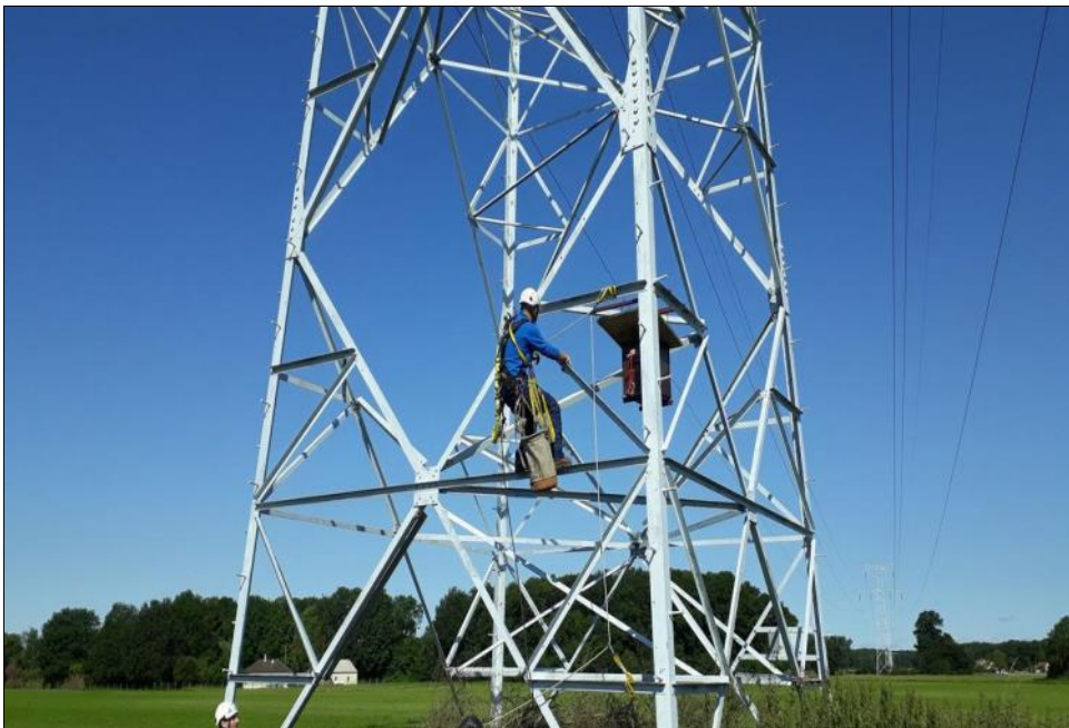
Le nichoir est installé sur un pylône.
