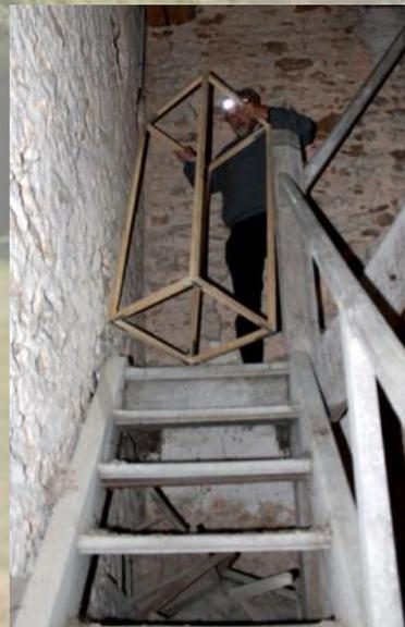
Dernière précaution : un « gabarit » à la taille réelle du futur nichoir permet de tester si ce dernier passe bien partout à travers escalier et ouvertures diverses jusqu'à son emplacement définitif...
