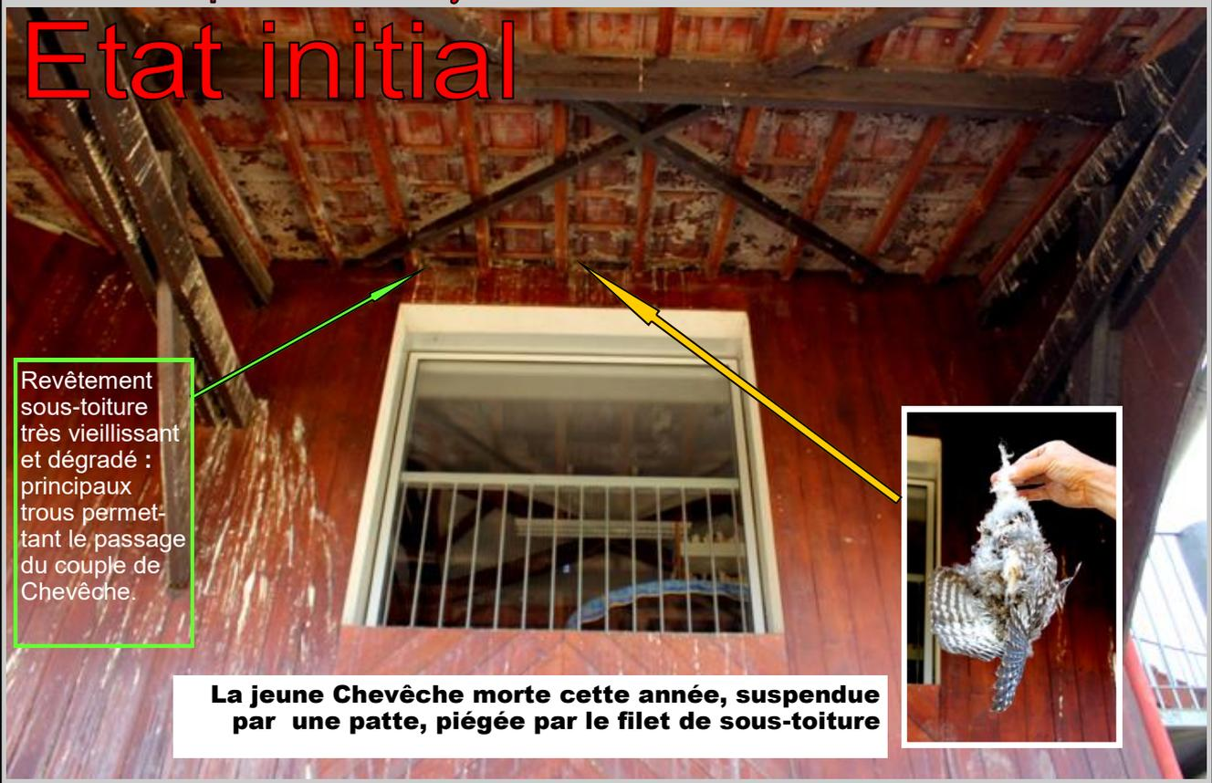
Revêtement sous-toiture très vieillissant et dégradé : principaux trous permettant le passage du couple de Chevêche.
