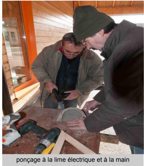
ponçage à la lime électrique et à la main
