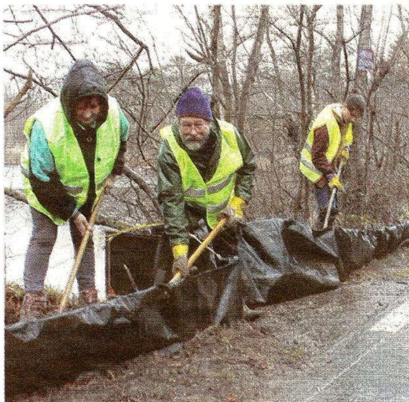
Les bénévoles de l'association Atena, en pleine construction du batracodrome.
