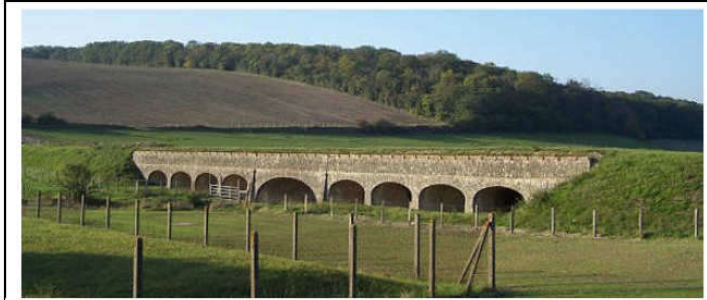
Pont en arc au fond de la vallée pour le franchissement de la Mauldre
