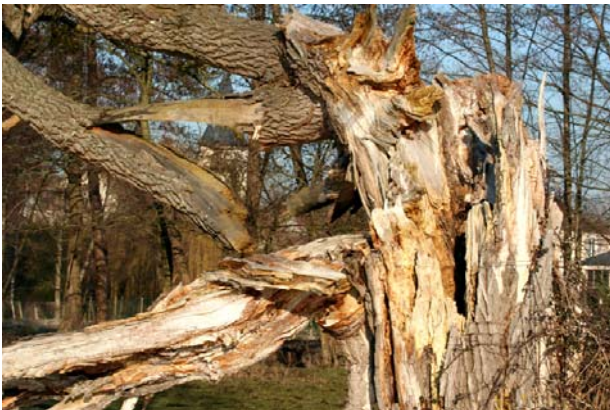
Voilà de la casse comme il en arrive chaque hiver. En se brisant, la branche cause une blessure importante en arrachant un morceau de la tête. L'eau s'y infiltre et les champignons s'y développent.
